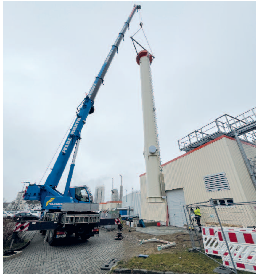
Nachdem das Heizkraftwerk an der August-Bebel-Straße bereits eine neue Kesselanlage erhielt, folgte Mitte März die Anlieferung des 20 Meter hohen und 9 Tonnen schweren Schornsteins.
