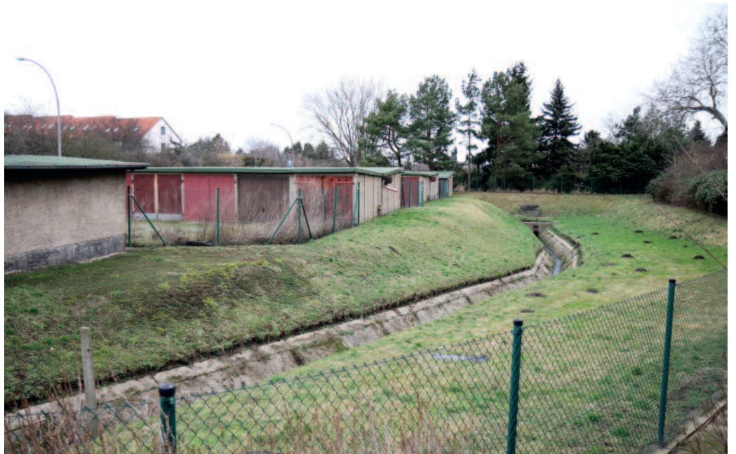
Das Rückhaltebecken soll erweitert werden. Dafür müssen die Garagen im Sauggrund weichen. Foto: U.P.
