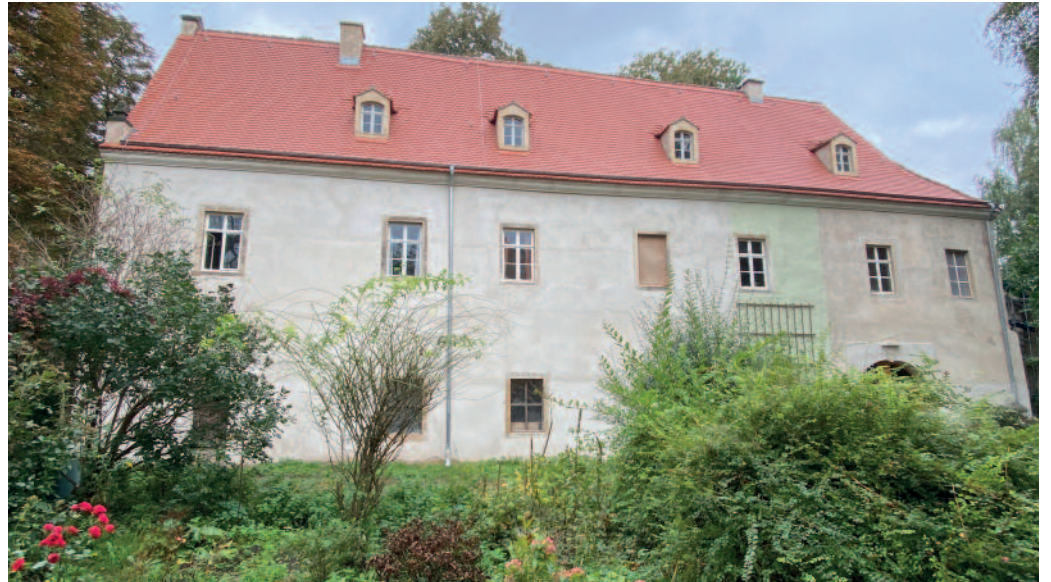
Mit neuem Dach und Putz wirkt Schloss Jahnishausen seit dem Sommer schon fast wie neu. Fotos: H.B.
