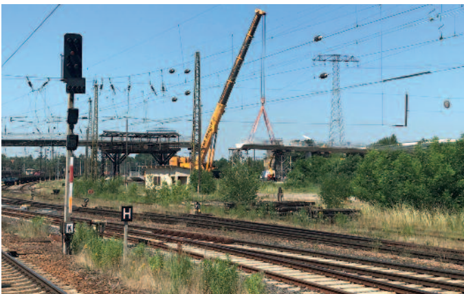
In der vorigen Woche wurden mit imposanter Technik die ersten zwei Felder der Brücke über die Bahngleise ausgehoben. Foto: U.P.
