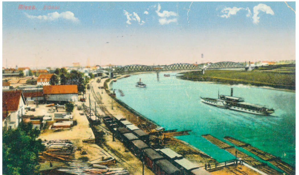
Der Riesaer Elbkai war 1892 von strengen Quarantäne- und Desinfektionsmaßnahmen betroffen.
