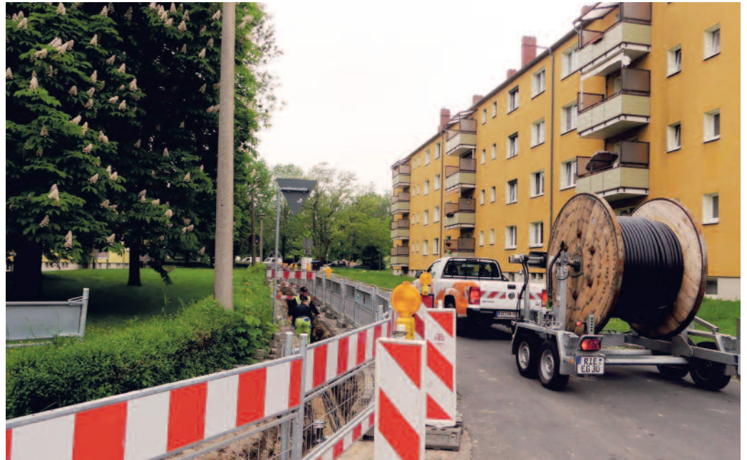
Um alle Riesaer rund um die Uhr sicher und zuverlässig mit Strom zu versorgen, ist die kontinuierliche Erneuerung und der Ausbau im gesamten Netzgebiet der SWR eine zentrale Aufgabe des Unternehmens.
