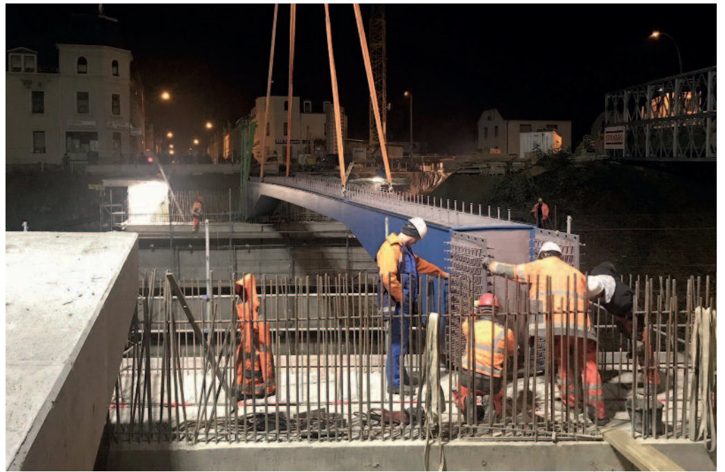
Echte Präzisionsarbeit: Alle Hauptträger konnten passgenau eingesetzt werden. Foto: B.F. – Stadtbauamt
