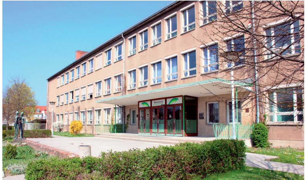
Die Sanierung der Oberschule Merzdorf hängt entscheidend von den Grundschul-Planungen ab. Foto: U.P.
