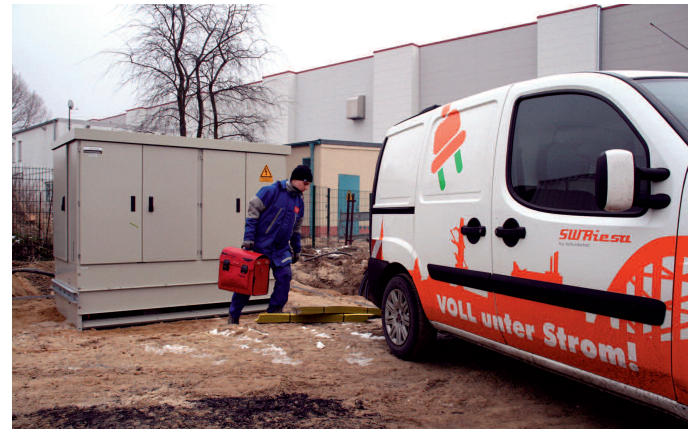
Unweit der Erdgasarena wurde eine neue Trafostation errichtet. Die neue Photovoltaik-Anlage auf dem Dach der Arena macht diese erforderlich.
