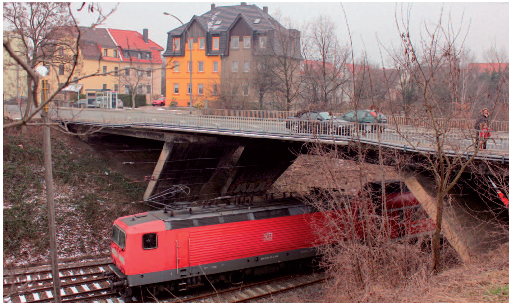
Die Tragfähigkeit der Brücke über die Bahnlinie nach Chemnitz wird in nächster Zeit geprüft. Foto: U.P.
