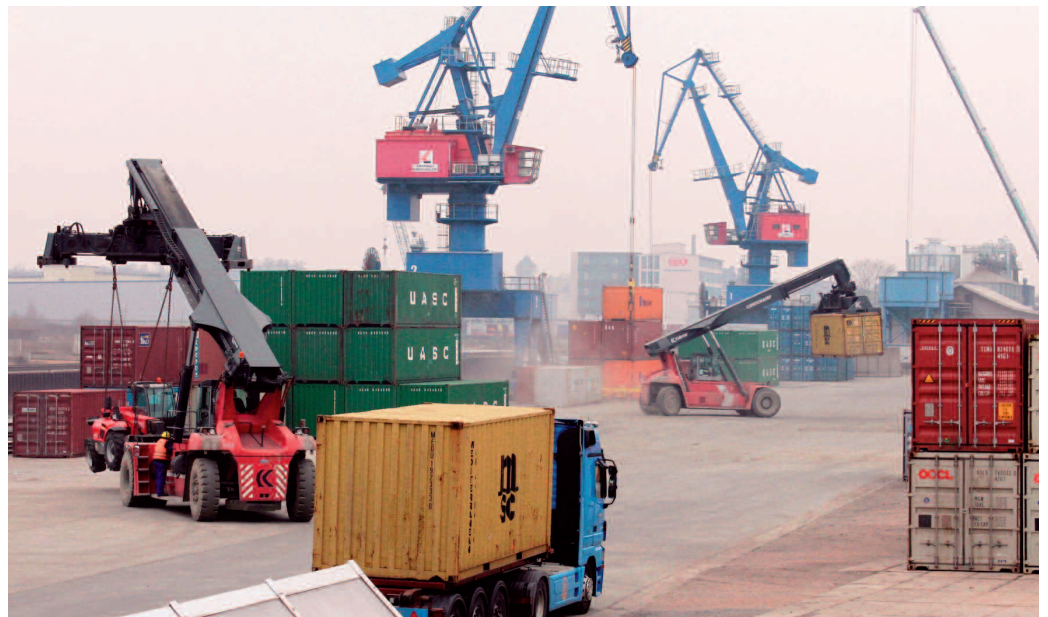
Reges Treiben auf dem Hafengelände: Riesa ist eine der stärksten Säulen im SBO-Verbund. Foto: U.P.
