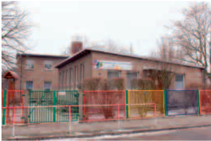
Hoffnungsschimmer: Die Sanierung der Kita „Kunterbunter Schmetterling“ ist im Stadthaushalt abgesichert.
