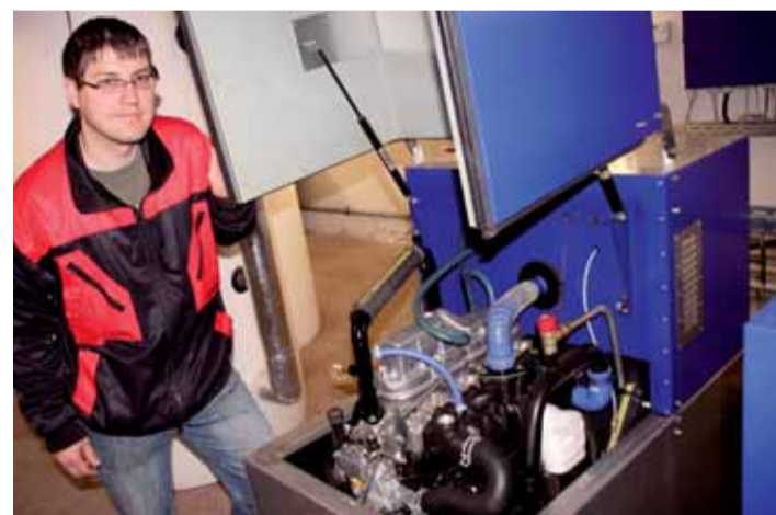
Wie hier das Werner-Heisenberg-Gymnasium (Foto: Mirko Muschalla, Technischer Leiter der ESAM) hat die Stadtwerke Tochter ESAM auch beide Häuser des Städtischen Gymnasiums, die Trinitatisschule, die Schule zur Lernförderung „An der Goethestraße“ und die Grundschule am Rathaus mit hocheffizienten Mini-Blockheizkraftwerken ausgestattet.
