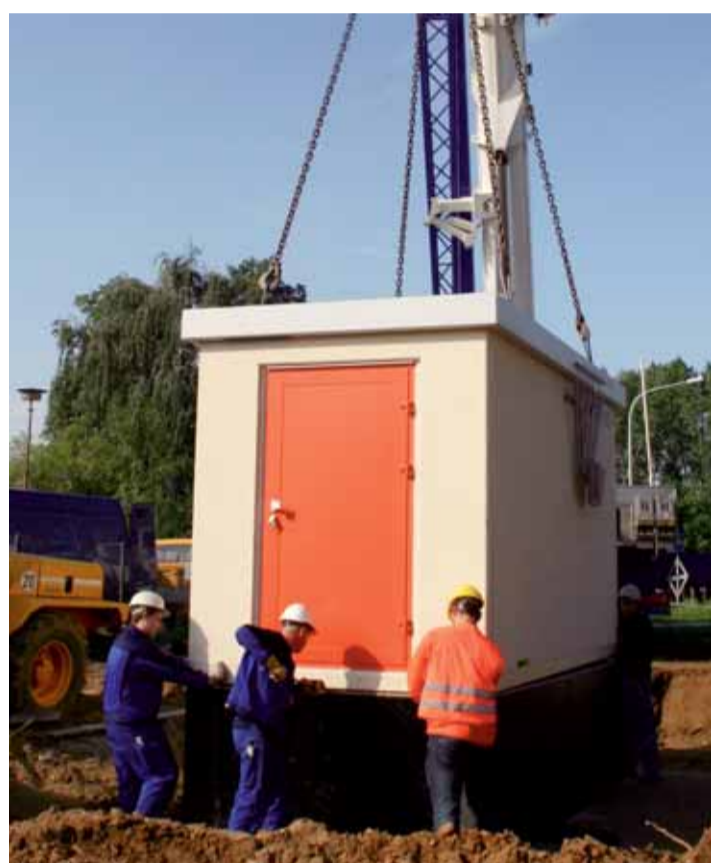
Gestern wurde die neue Gasdruckregelstation an der Freitaler Straße errichtet.
