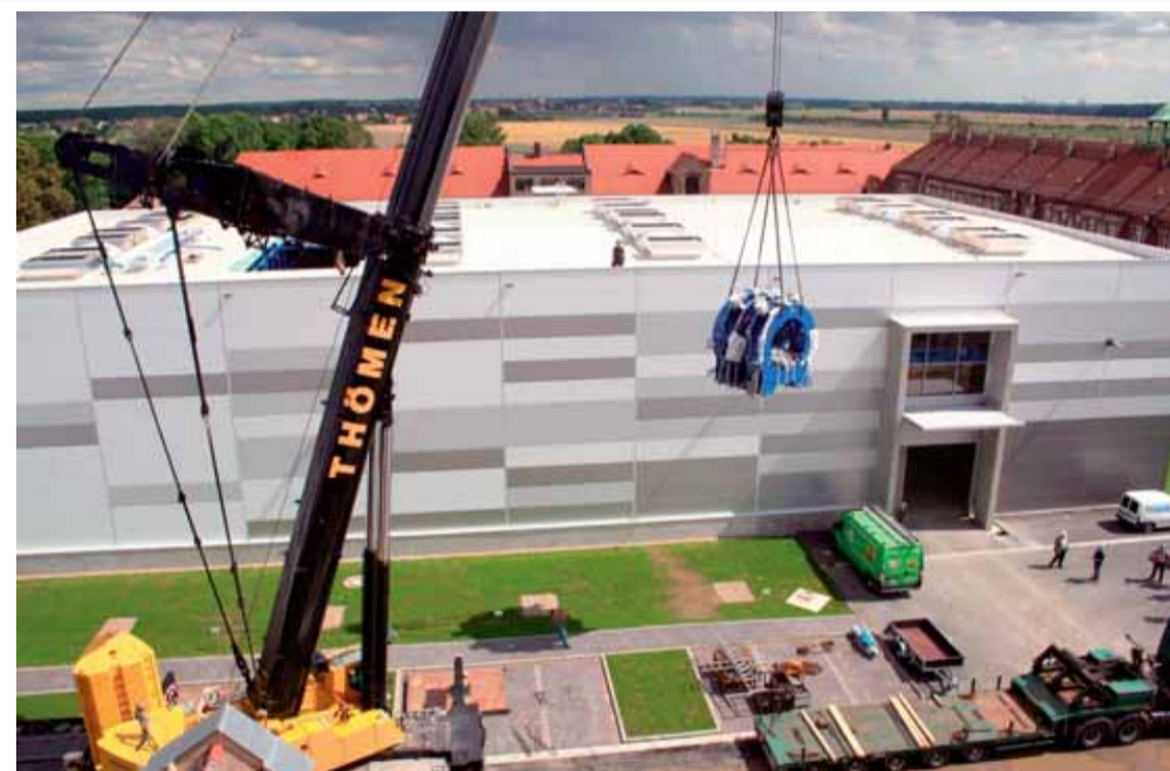
Vom Dachboden der Riesaer Feuerwehr bietet sich dieser faszinierende Blick über den künftigen Forschungs- und Gewerbepark Gröba. Im Vordergrund hebt der Kran das erste Segment des Walzaggregats durch das Dach der Forschungshalle ein. Hier werden Experten aus aller Welt künftig Tests und Forschungen zur Herstellung nahtloser Rohre vornehmen.
