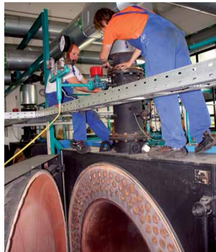
SWR-Mitarbeiter bereiten einen Kessel im HKW Elbufer für eine TÜV-Untersuchung vor.
