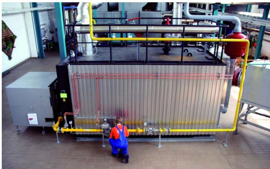
Im Mai wurde im Heizkraftwerk Weida ein neuer Heißwasserkessel mit einer thermischen Leistung von sechs Megawatt installiert. Er ersetzt einen alten Dampfkessel (3,5 MW), wird mit Erdgas betrieben, wurde in Deutschland hergestellt und verbessert die Schadstoffemissionen. Damit befindet sich die Anlage bereits mehrere Monate vor Beginn der Heizperiode auf modernstem Stand.
