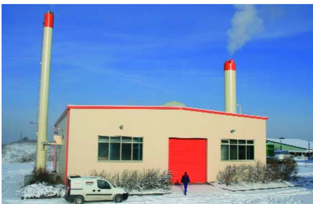
Rund 9.000 Riesaer Haushalte verlassen sich vor allem im Winter auf Fernwärme der SWR. Damit die modernen Erzeugungsanlagen rund um die Uhr sicher funktionieren, werden sie unter anderem regelmäßig von SWR-Mitarbeitern kontrolliert (Bild: Heizkraftwerk Pausitz).
