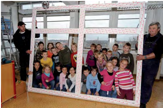
In der vergangenen Woche wurden die neuen Fenster in der Schule Collmblick eingebaut.
