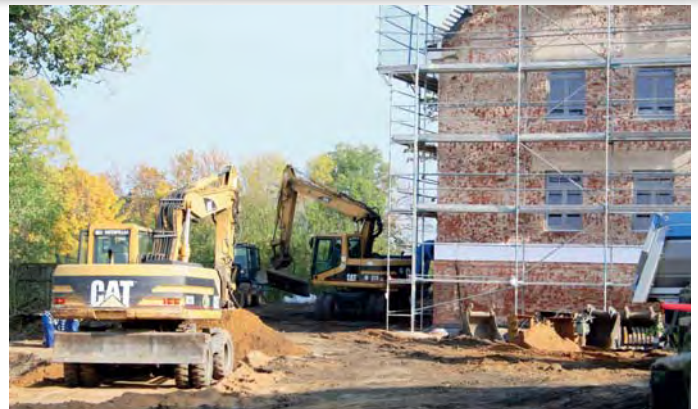
Die Kastanienstraße bildet den 1. Bauabschnitt zur Erschließung des Gewerkeparks Gröba.
