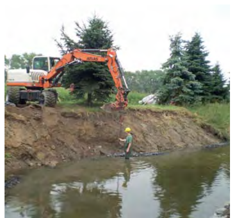
Die Döllnitz hat am Dreibrückenweg jetzt wieder freie Bahn – ein altes Wehr wurde entfernt – das hilft der Tierwelt und dem Hochwasserschutz.
