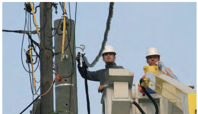
In der Walther-Rathenau-Straße haben die Stadtwerke Riesa, im Bild René Bäger (l.) und Frank Vogel, neue Betonstrommasten gesetzt und ein neues Luftkabel gezogen. Am Freitag, dem 14. August, wurden die Arbeiten beendet.
