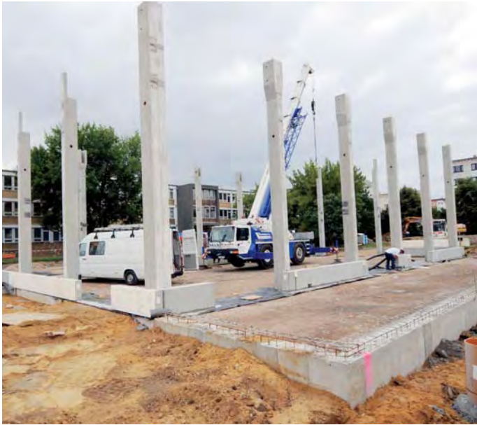
16 Stützen für den Bau der neuen Einfeldsporthalle im Wohngebiet Oschatz West wurden in der vergangenen Woche montiert. Jede der Stützen ist 8,65 Meter hoch, danach erfolgte die Montage der Sockelelemente, die Bindermontage soll diese Woche abgeschlossen sein.
