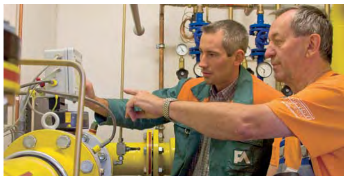
Die SWR liefern auch für das nächste Gaswirtschaftsjahr Erdgas an die Elbe-Stahlwerke Feralpi, die den umweltfreundlichen Energieträger für ihre Produktionsprozesse einsetzen. Abgebildet: ESF-Mitarbeiter Jan Karl (l.) und SWR-Gasmonteur Fritz Hagedorn bei einer Kontrolle in der Gasdruckregelstation auf dem Gelände des Stahlproduzenten.
