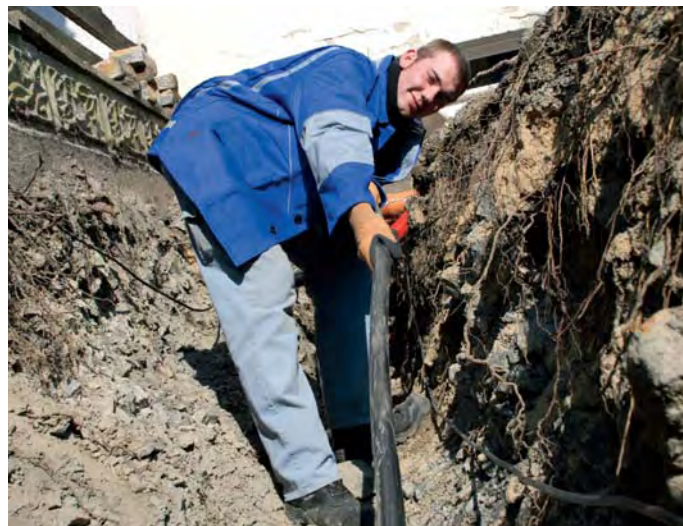
Packt am liebsten an: Dustin Zenker zieht ein Stromkabel für einen Hausanschluss zurecht.
