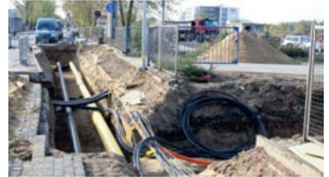
wurden Leitungsröhre für die Gasversorgung und Kabelstränge für die Elektrik verlegt. Produktionsstart in der neuen, knapp 10.000 Quadratmeter großen Halle des Reifenwerks ist im Sommer des nächsten Jahres.
